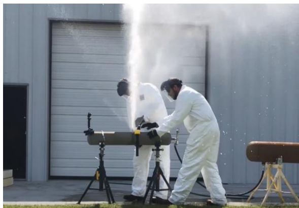
Naprawa wycieku pod ciśnieniem 14 bar.
