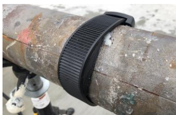
Krok 1: Zatrzymany wyciek na aktywnym rurociągu przesyłowym.
